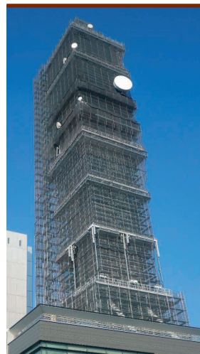
施工例：株式会社NITTO 様HPより
