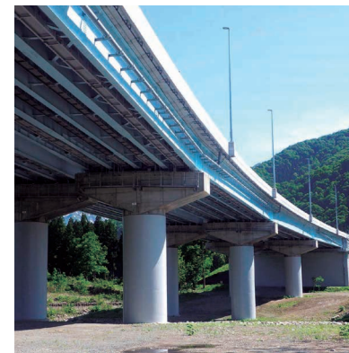
施工例：株式会社NITTO 様HPより
